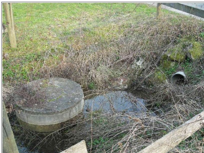
Le ruisseau du village est équipé de trois puits d'infiltration au niveau du hameau des ROUTES. On voit sur la photo le tampon de l'un d'eux. On aperçoit également le busage qui communique avec un autre ouvrage situé à l'aval de la route.
