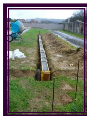
Mur de soutien cimetière Coût : en cours
