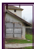
Porte Garage Rénovation toiture Cour Mairie
